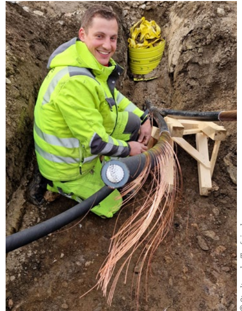
Neue Kabel für mehr Leistung
